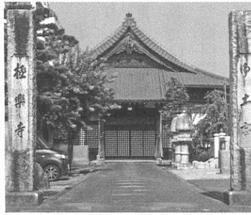
正面の本堂は、明治13年の大火災の後、同45年に再建されたもので、平成7年に改修を行った。
